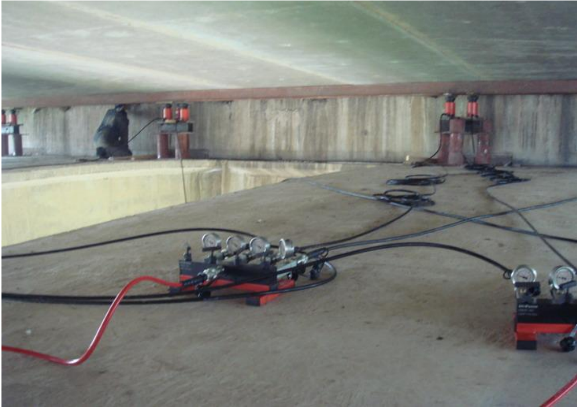
الصورة (٦): عملية رفع المنشأ العلوي للجسر.
