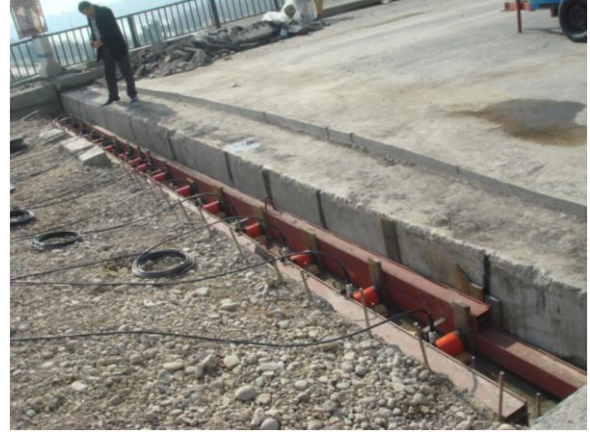
الصورة (٤): نصب ستة عشر جك هيدروليكي نوع HFG504 في أماكنها.
