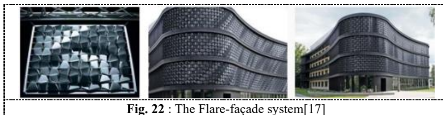
Fig. 22 : The Flare-façade system[17]
